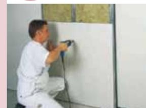
Tagliare le lastre ad un'altezza pari a quella del locale ridotta di 10 mm. Disporre le lastre verticalmente sulla struttura metallica sollevate 10 mm dal pavimento aiutandosi con uno spessore o un sollevatore di lastre a pedale. Avvitare le lastre sui montanti procedendo dall'alto verso il basso.
