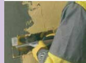
Ad operazione finita il tutto deve asciugare per almeno 2 giorni. Procedere quindi alla seconda mano di rasante con spatola d'acciaio non dentata in modo da coprire completamente la rete d'armatura.
