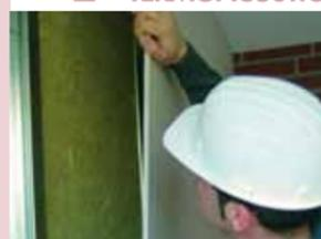
La soluzione ideale è costituita da pannelli in lana minerale autoportanti eventualmente accoppiati con opportuna barriera al vapore. I pannelli devono essere inseriti fra i montanti, lo spazio fra le ali del montante vincola lo spessore massimo del pannello.
