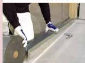
Per limitare le trasmissioni acustiche laterali si deve applicare sull'anima della guida il nastro biadesivo.
