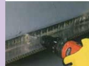
In funzione dello spessore del pannello isolante scegliere la larghezza del profilo metallico in modo che il pannello si incastrerà perfettamente all'interno del supporto di partenza. Fissare al muro il profilo di partenza che deve rimanere sollevato 2 cm circa da terra.
