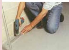
Tracciare sul pavimento la posizione della guida ad una distanza dalla parete pari allo spessore del pannello isolante. Con il laser o il filo a piombo determinare la posizione della guida a soffitto. Fissare la guida con opportuni fissaggi ogni 50 cm.
