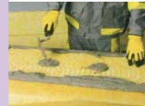
Per incollare i pannelli, applicare l'adesivo in punti con cazzuola con un consumo medio di 2-4 kg/m<sup>2</sup>. Il prodotto viene steso in modo da formare delle strisce di qualche centimetro di larghezza parallele ai lati della lastra isolante e al centro dei punti a spessore con un diametro di circa 5-10 cm.
