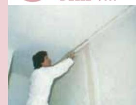
Disporre il nastro rete adesivo centrato all'interno del giunto. Preparare lo stucco che deve raggiungere la consistenza di un "budino" e aiutandosi con una spatola disporlo nel giunto fino a creare una superficie perfettamente complanare. Lasciare asciugare lo stucco ( il tempo di presa dipende dalla composizione e dal tipo di stucco ) prima di procedere
