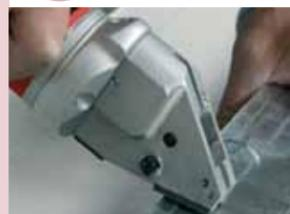
I montanti a C devono essere tagliati ad una lunghezza pari alla distanza fra le guide diminuita di 10 mm. Le asole laterali per il passaggio degli impianti solitamente vengono poste nella parte bassa delle pareti.
