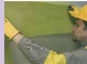
Montate le lastre isolanti, si deve attendere per almeno 2-7 giorni (dipende dalle condizioni climatiche) per la rasatura ed annegamento della rete di armatura. Procedere alla rasatura con spatola metallica dentata. Partendo dall'alto verso il basso, inserire e annegare la rete d'armatura sovrapprendendola tra una striscia e l'altra per almeno 10 cm. Consumo medio di 1,5 kg/m<sup>2</sup> per 1 mm di spessore.
