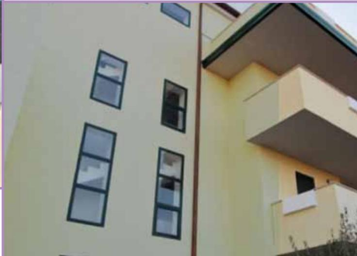
Gli edifici rappresentati, realizzati interamente con la tecnologia a secco, hanno raggiunto un grado di finitura estetica e di confort termoacustico superiore che non ha nulla da invidiare all'edilizia tradizionale
