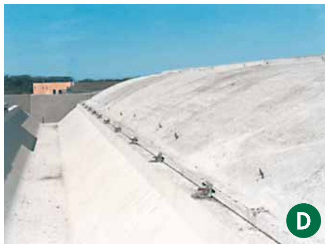
▲ Dettaglio del coppone in corrispondenza delle canale raccolta acqua piovana.
