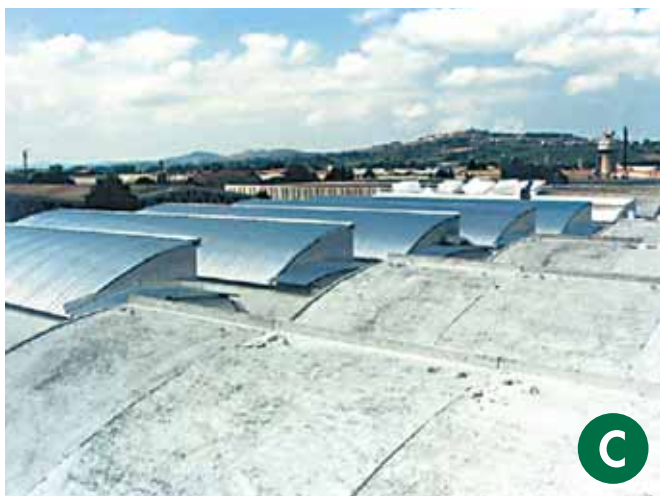
▲ La realizzazione della copertura dei copponi con lastre curvate con calandra micronervata.
