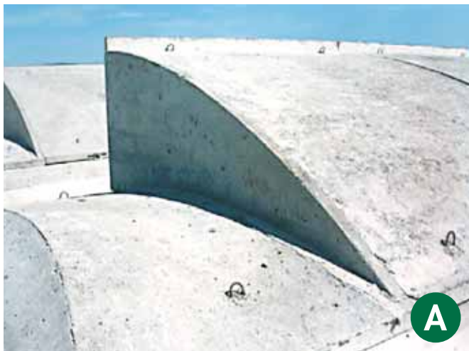
▲ Dettaglio del coppone in corrispondenza delle finestrature.
