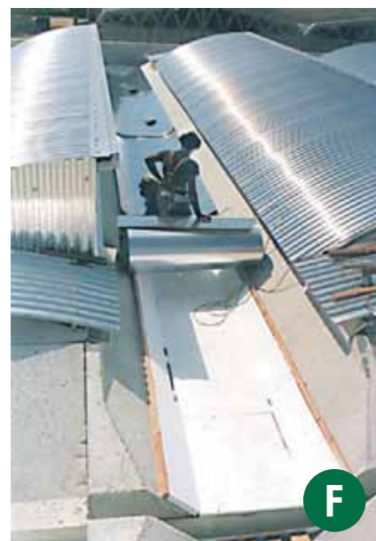
▲ Dettaglio del coppone in corrispondenza delle canale raccolta acqua piovana.
