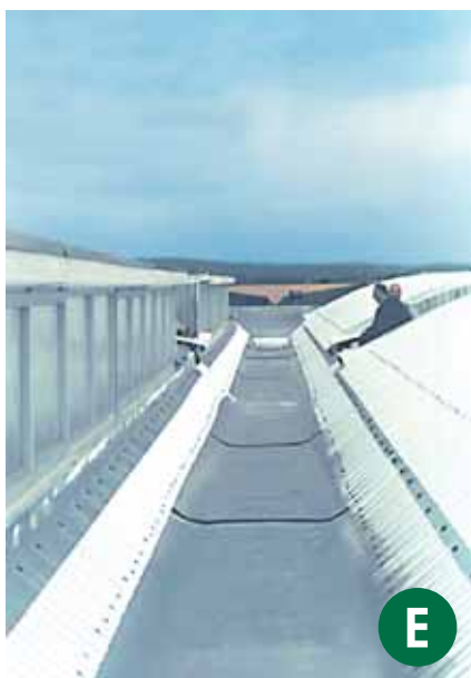
▲ La realizzazione della copertura dei copponi con lastre curvate con calandra micronervata.
