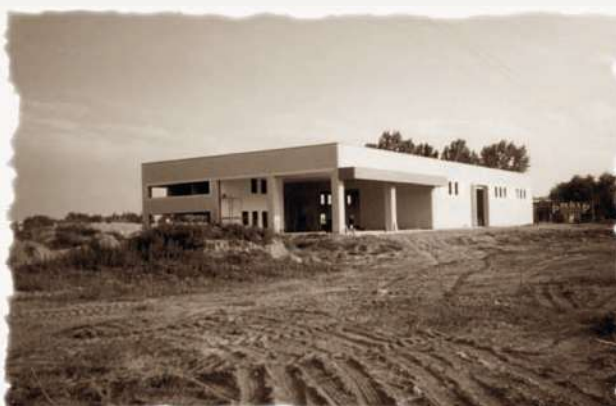
Inizio costruzione sede attuale 1993
