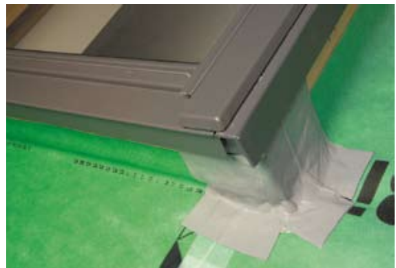
Fig. 12: Attacchi alla finestra del tetto nastri con USB COLL 80
