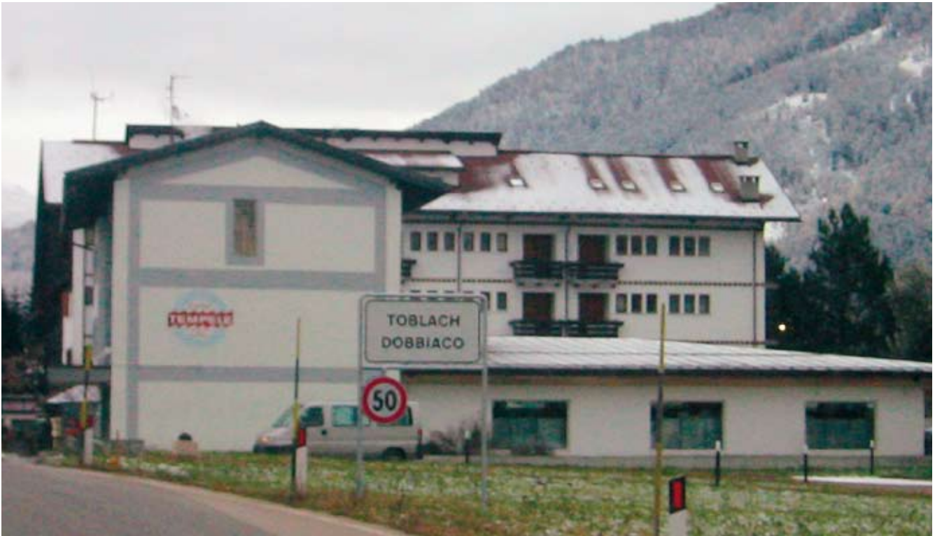
Fig. 8: Immagine termografica „naturale“: la neve sciolta per la permeabilità all'aria sopra le finestre del tetto ha creato l'immagine termografica
