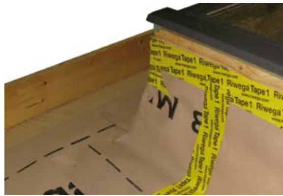
Fig. 10: Sovrapposizione del telo USB MICRO chiuso con nastro adesivo USB Tape 1 PAP
