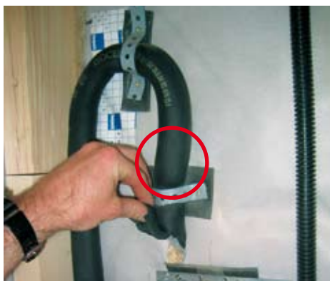
SBAGLIATO: Tubo non collegato ermeticamente al freno al vapore
