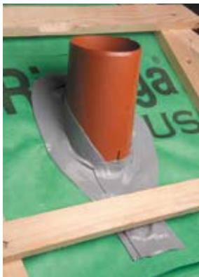
Fig. 13: Condotte di ventilazione impermeabilizzato con USB COLL 80
