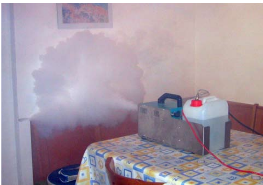
Macchina del fumo per l'analisi di tenuta.
