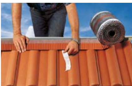
4. Posa in opera del gancio fermacolmo e della tegola di colmo sulla linea di colmo
