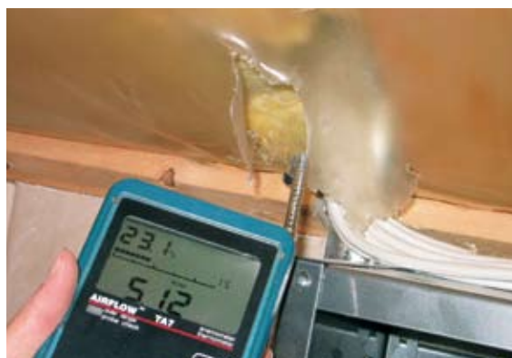
SBAGLIATO: Freno al vapore danneggiato a causa dell'installazione errata dei cavi d'antenna.
