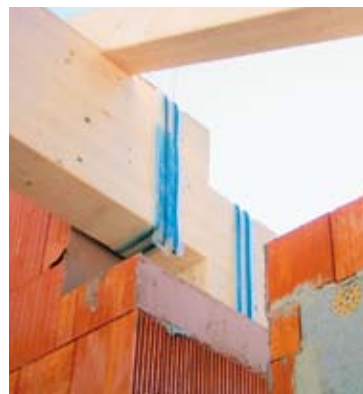
Fig. 16: Travi protetti con GAE ST 125/10 per la tenuta all'aria
