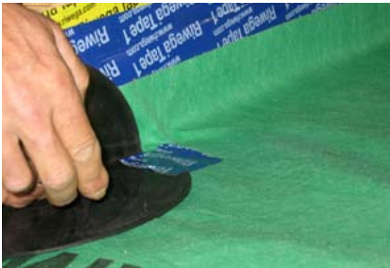
Fig. 11: Sovrapposizione USB CLASSIC con USB TAPE 1 PE
