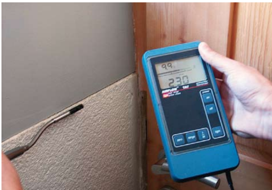
Analisi delle perdite d'aria con termoanemometro
