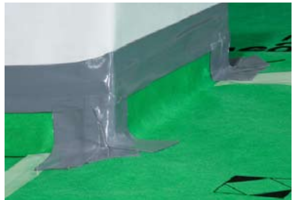
Fig. 14: Attacco del camino nastri con nastro butilico USB COLL 80
