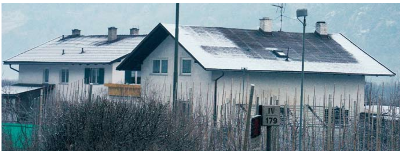
Fig. 20: termografia "naturale"; la neve sciolta sopra l'edificio riscaldato
